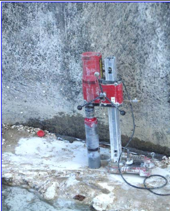
Esecuzione carotaggio su plinto di fondazione.
