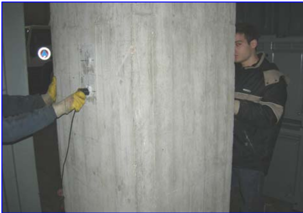
Esecuzione indagine ultrasonica.
