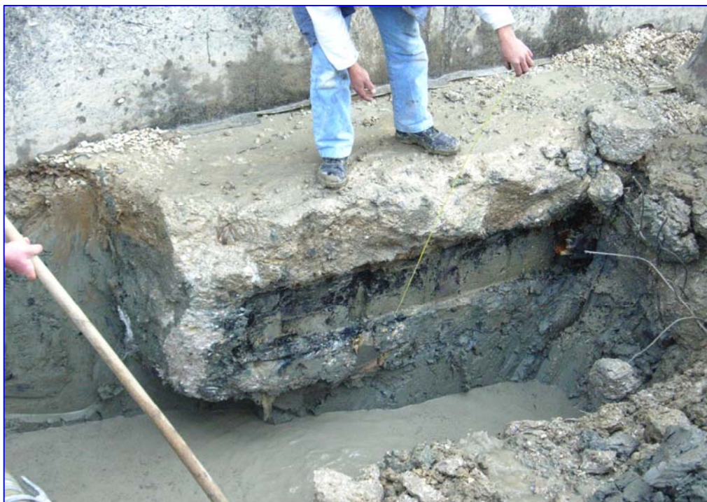
Esecuzione scavo per consentire l'individuazione delle strutture fondali.
