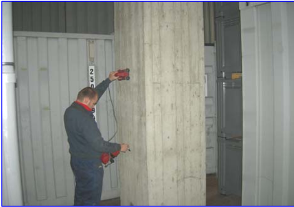
Esecuzione indagine pachometrica.
