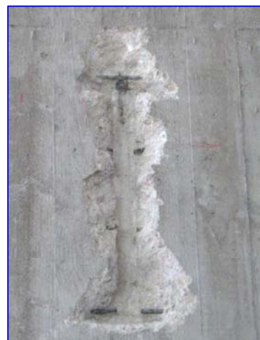
Rilievo diretto dei ferri di armatura.
