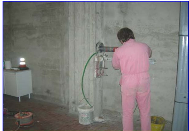
Esecuzione estrazione carota in cls da pilastro.
